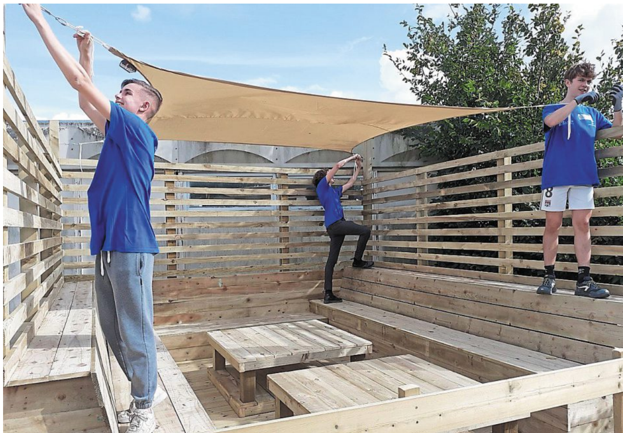
Les étudiants se sont relayés pour construire des espaces de détente.
